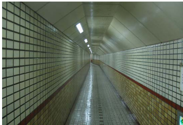
安治川トンネル内部
